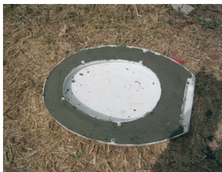
Photo 6-17 : Béton ajouté au siège de latrine
