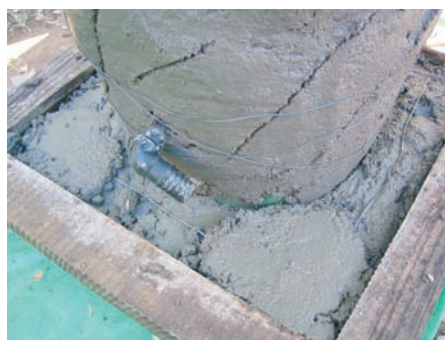
Photo 6-23 : Fil de fer supplémentaire pour le renforcement
