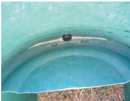
Photo 6-26 : La partie supérieure du séparateur est scellée
