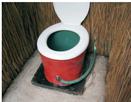
Photo 6-31 Siège à séparation d'urines installée.
