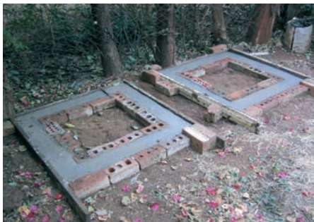
Photo 6-47 : Moulage des soubassements
