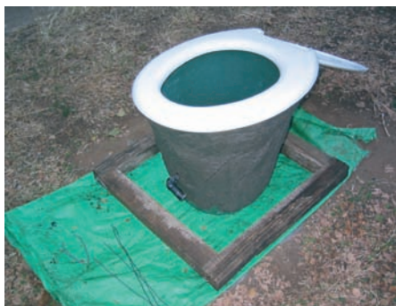
Photo 6-22 : Seau et siège retournés et placés dans un moule de base
